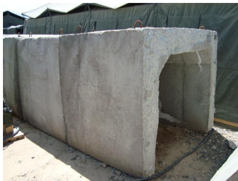
65. sz. ábra. Vasbeton alagút elemek (forrás: saját fotó)
