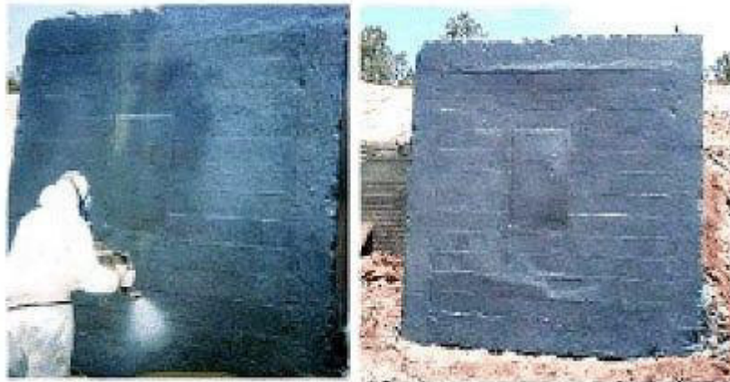
34. sz. ábra. A polimer réteg felhordása és a falazat robbantási teszt utáni állapota (forrás: http://www.linex.com/pages/2010/military/case_studies/masonry_wall_retrofit.php 2011. 05.05)
