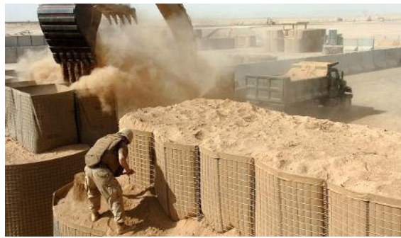
64. sz. ábra. A fémhálós keretek földdel való megtöltése történhet gépi vagy kézi erővel 146 (forrás: www.army-technology.com 2010. 05.01)
