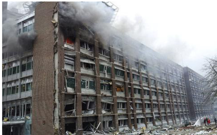
16. sz.. ábra. Kirobbanó vázkitöltő falazat és ablakszerkezet az oslói miniszterelnöki hivatal épülete előtt (forrás: http://nol.hu/kulfold/robbantas_az_osloi_kormanyepuleteknel 2012.02.19.)
