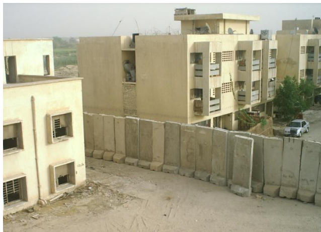
59. sz. ábra. Felül összekötött betonelemekből alkotott kerítés (forrás: Dr. Baráth Sándor alezredes úr)
