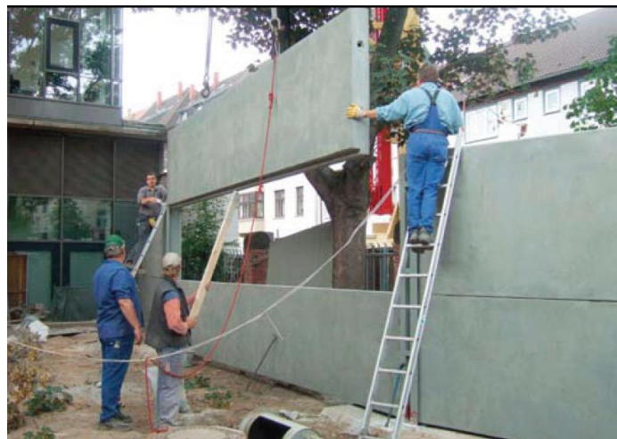
29. sz. ábra. Mikro-vasalatú beton elemek helyszíni öntése és beemelése (forrás: http://www.structuremag.org/article.aspx?articleID=600 2010.02.26.)
