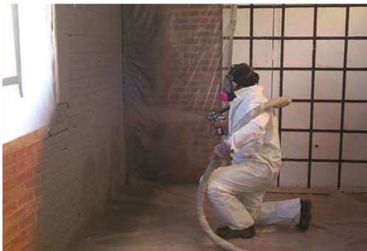
36. sz. ábra. Polimer réteg felhordása a falazatra és a teszt utáni állapot (forrás: http://www.linex.com/pages/2010/military/products/px_3350.php 2011. 05.05)
