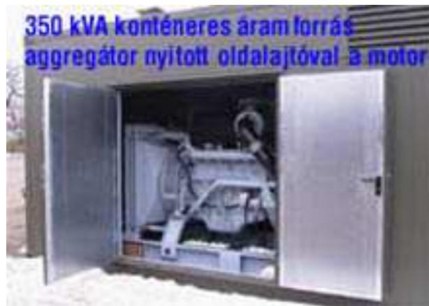
29. számú ábra: Áramforrás aggregátor konténerbe szerelve [59]
