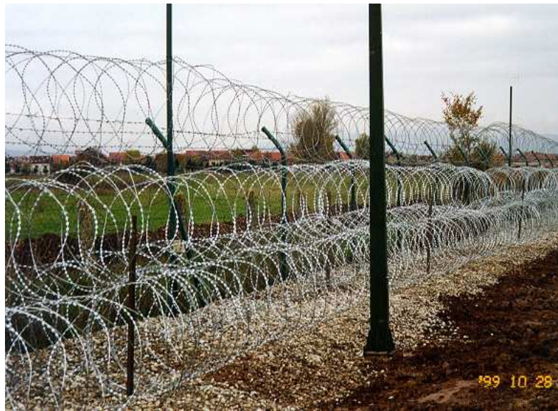
17. számú ábra 91 Drótakadály elhelyezése
