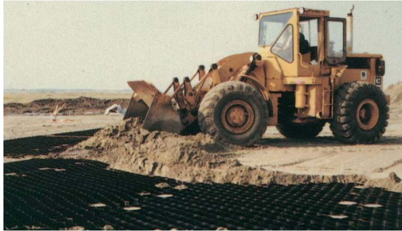
4-3. ábra: A Geocellák beépítése 167
