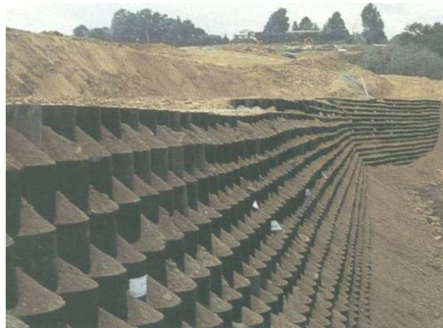
4-20. ábra: Geocellából készült támfal 195
