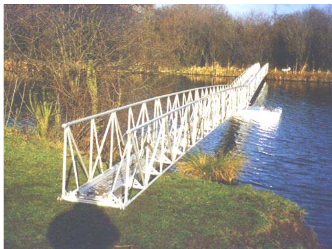
4-13. ábra: EWK-5 típusú, német fejlesztésű alumínium katonai gyaloghíd 185
