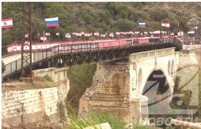
4-15. ábra: A SARM-M készlettel helyreállított al-Damour híd
