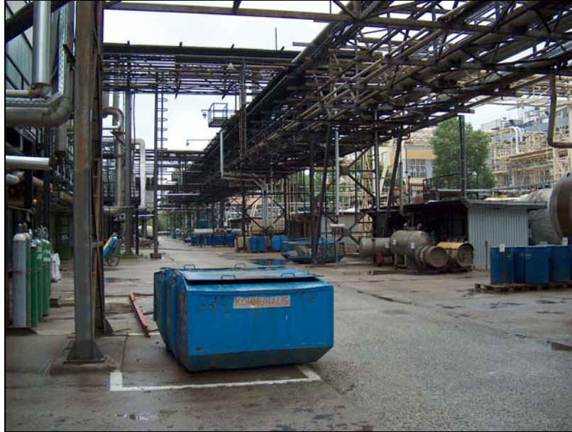
42. ábra: Irányfotó a gyárudvaron, a felmért csőhíd felé nézve (saját forrás)
