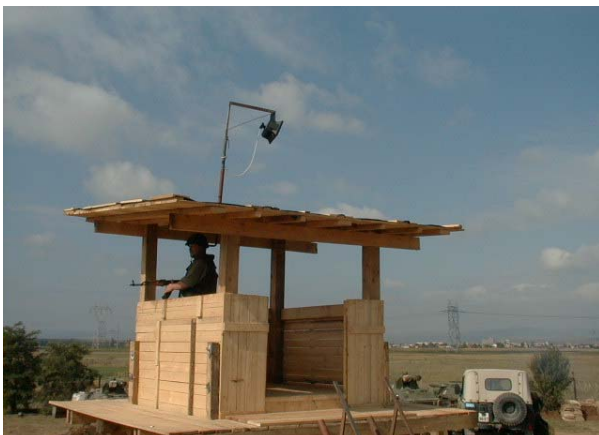
5. számú ábra Épülő őrtorony Pristinában (forrás: szerző)
