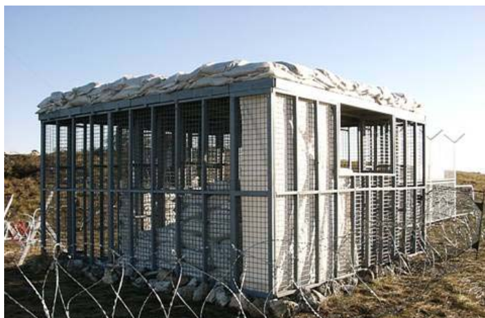
17. számú ábra Könnyűszerkezetes fedezék (forrás: Callmix Kft.)
