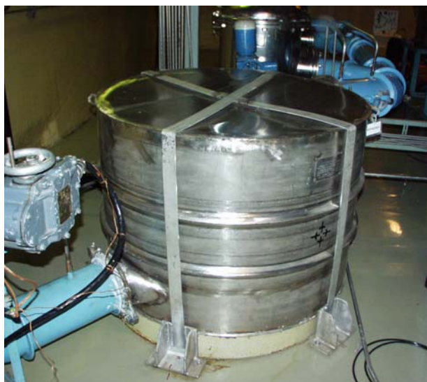
2.3. ábra AU-1500 jódszűrő a TN02 rendszerben
