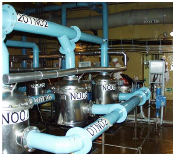
2.1. ábra C-500 aeroszol szűrők TN02 rendszerben
