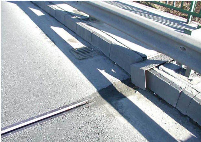
2-6 Dilatációs szerkezet hibája 56
