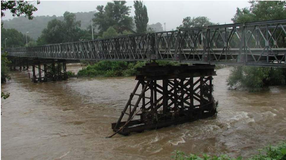
2-5 ábra Egyenlőtlen süllyedés és ellene való védekezés Doboj III. hídnál 55
