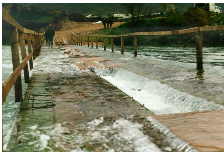
3-12 ábra TMM-3 híd Ustikolinánál 102
