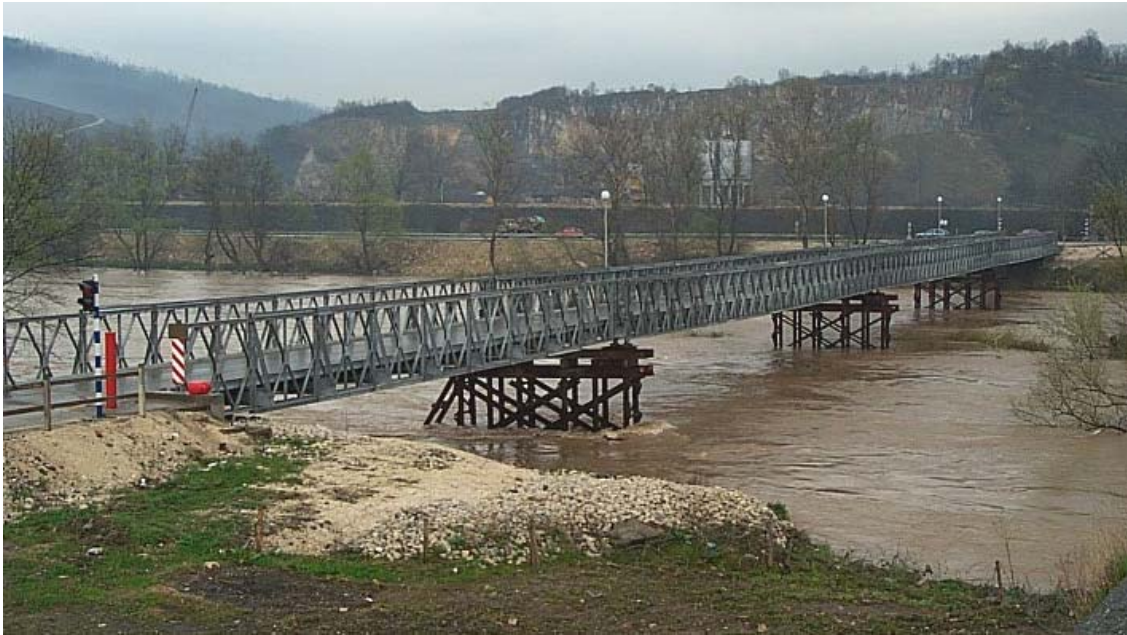
3-7 ábra Doboj III., M & J híd 96
