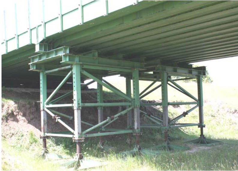
3-16 ábra SBG 66 hídprovizórium 110
