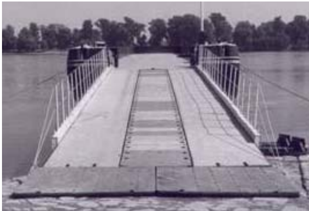
1-4 ábra Közút TS uszályhíd 10
