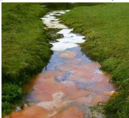
5. számú kép – nyílt patakmeder szénhidrogén-szennyezésének olajfelitató lapok használatával
