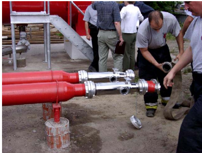
14. kép: Nagy ellennyomású habsugárcső alkalmazása habforrásként
