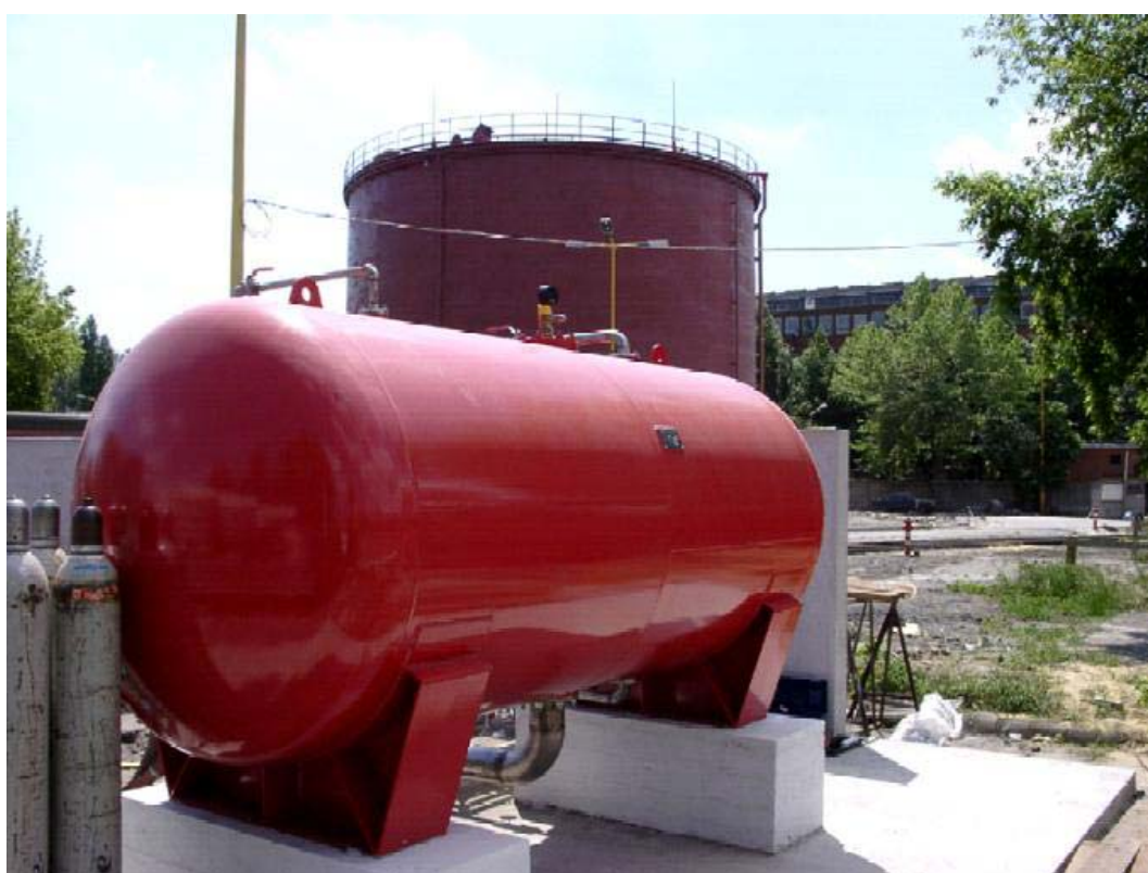
22. kép: Az Újpest Erőmű 5 000m 3 -es kerozin tartályának habellátó rendszere
