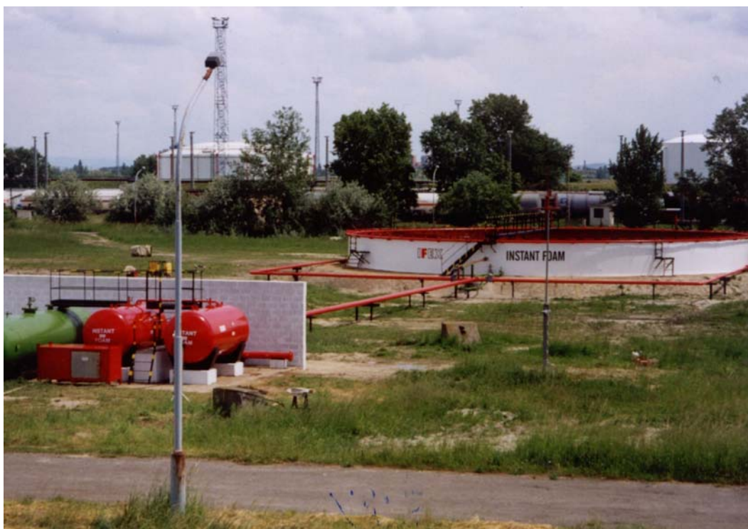
10. kép: A habtároló tartályok és a habvezetékek
