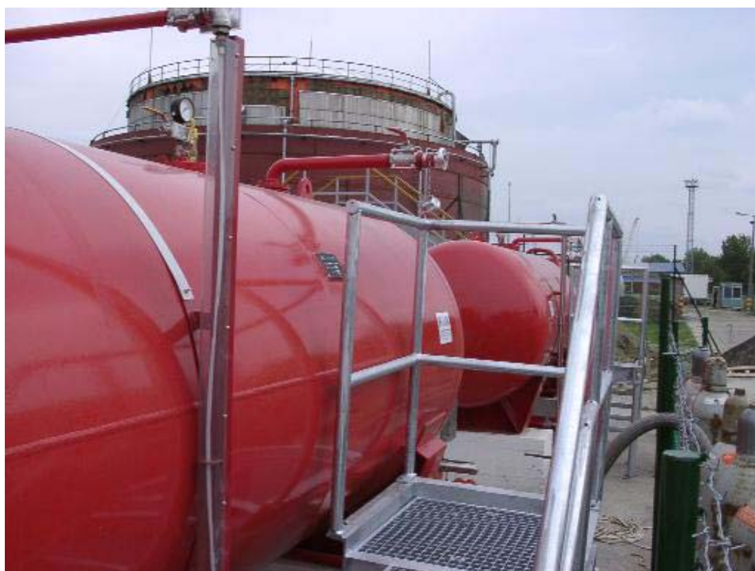
26. kép: Csepel, Oil Tanking Co. telephelye, 5000 m 3 -es benzintartály védelmének habellátása
