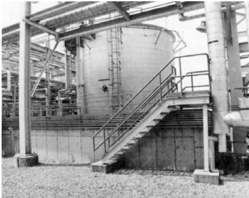
75. ábra. Biztonsági kármentővel ellátott tartály (Forrás: [62–64] alapján)
