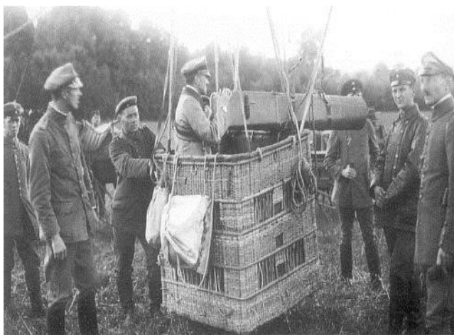
Kodak gyártmányú német katonai ballonkamera
