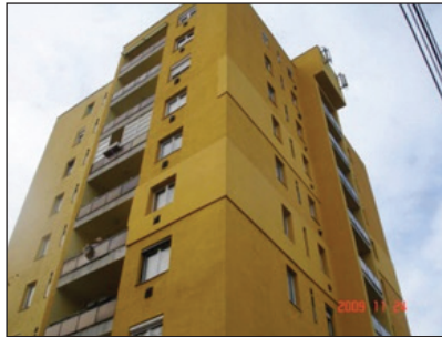
7. kép • A hőszigetelés lakásonként is felragasztható
