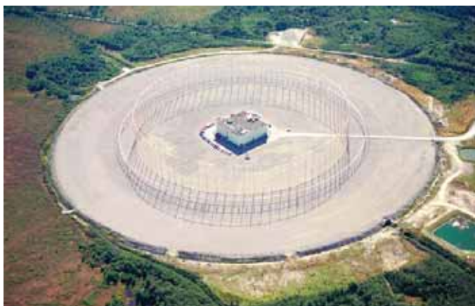
3.2. kép. Wullenweber iránymérő antennájának felépítése 156
