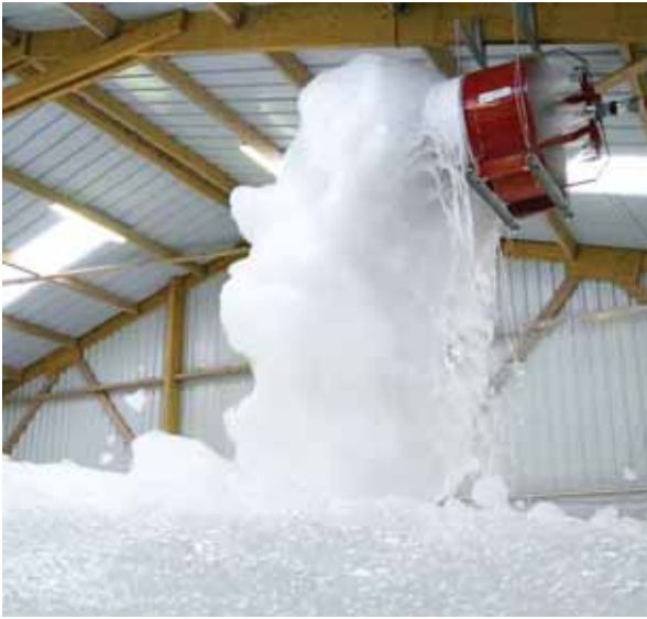
97. ábra: Könnyűhab előállítása habgenerátorral
